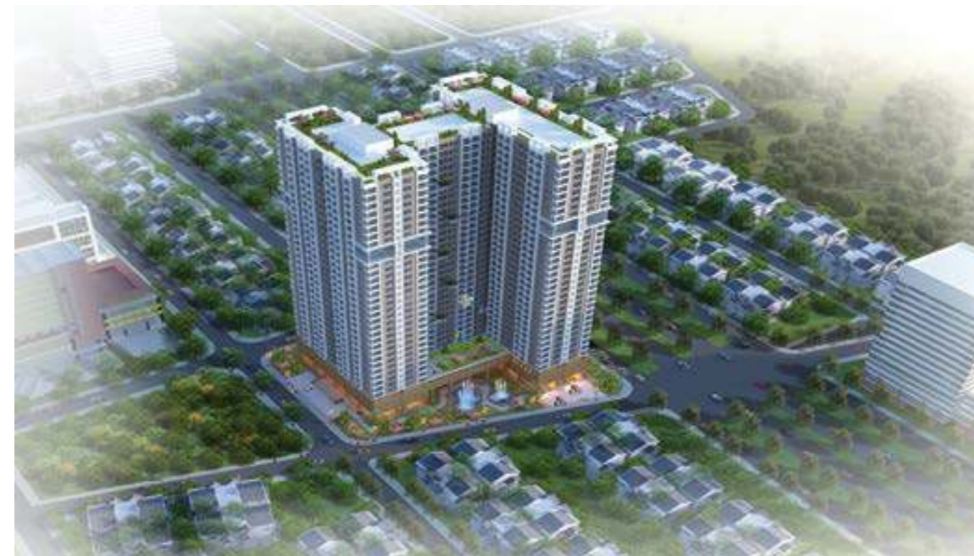
5. GEMEK TOWER 2 - Le Trong Tan St., Ha Dong Dist., Hanoi
